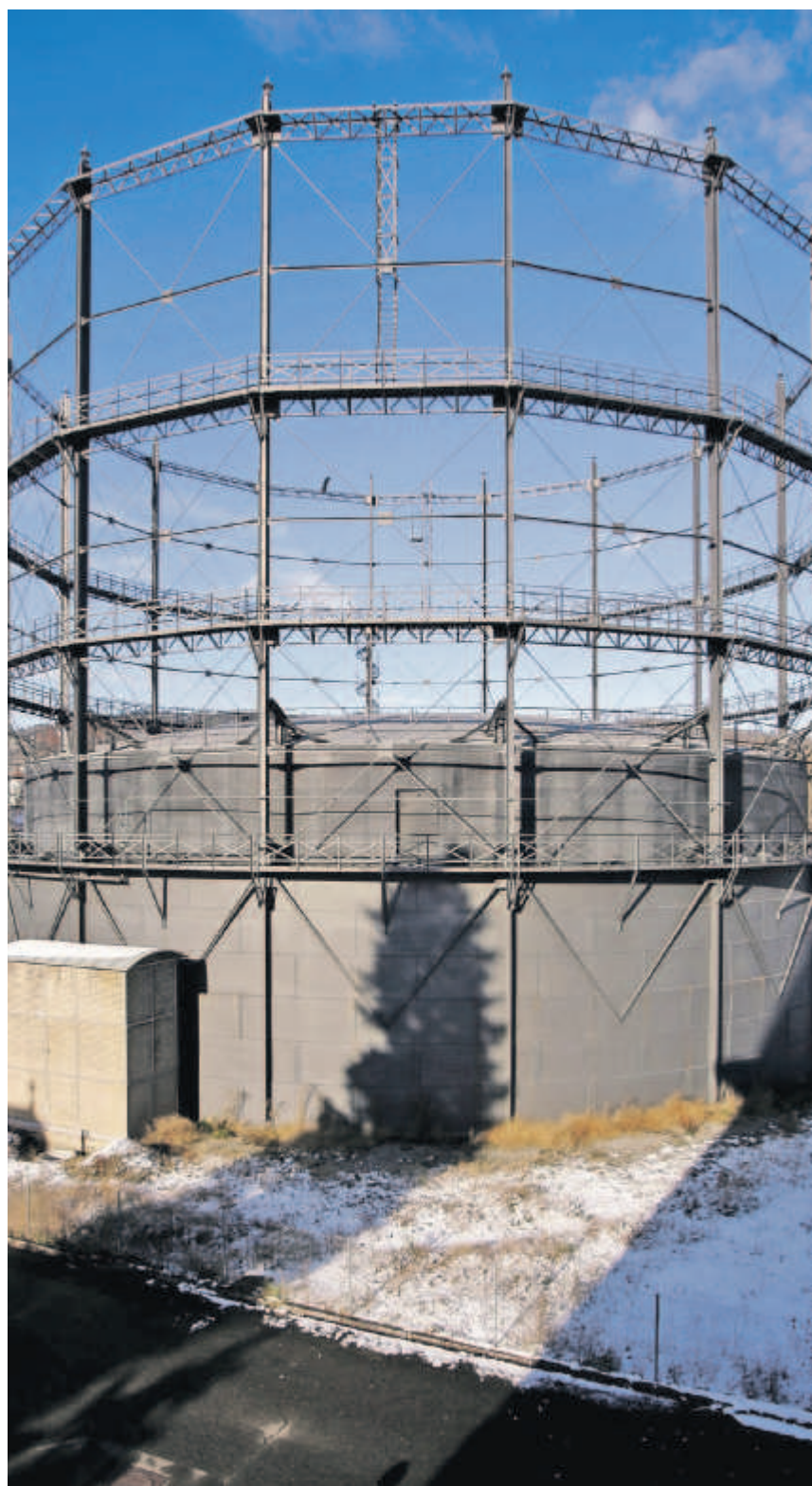
Der letzte Gasometer in Schlieren ist kurz vor dem Abriss gerettet worden. Bild: key
